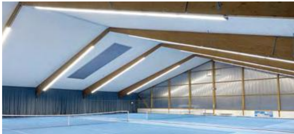
TG Veitshöchheim: Komplettanierung der 3-Feldhalle mit Spitzenlicht aus Penzberg
